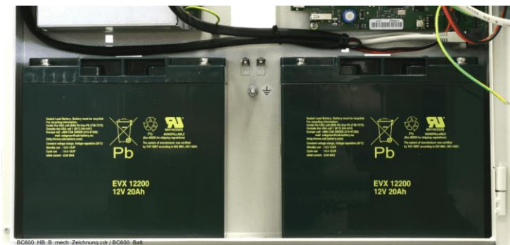
Obr. 2: Pozice instalovaných záložních baterií na dně skříně protipožární ústředny BC600-8xxx
